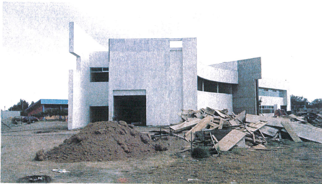
Avance del Edificio tipo S.
